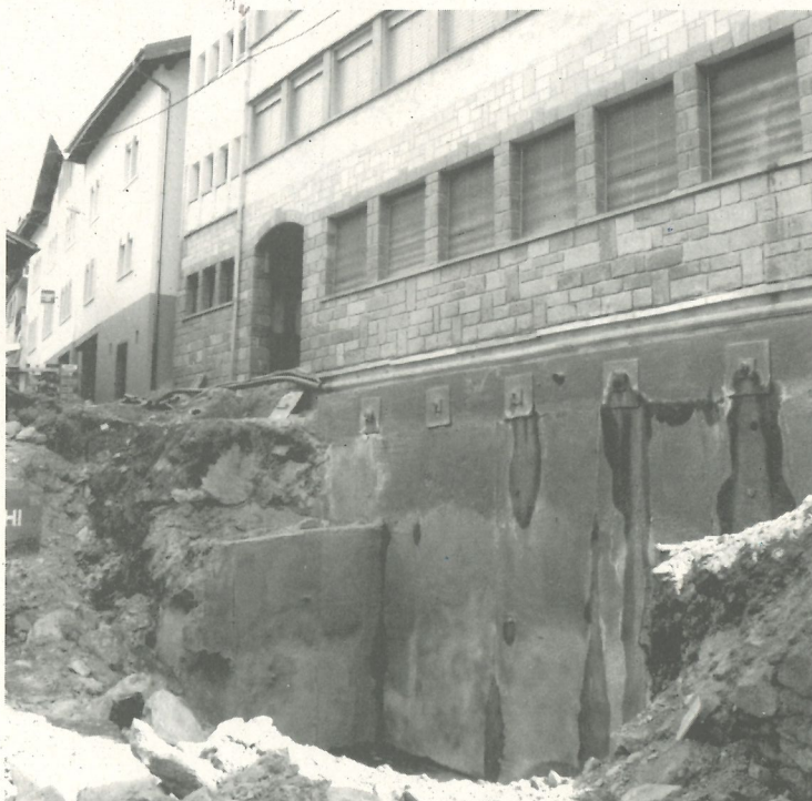
Excavation pour le silo à 8 m sous les fondations de l'école.
